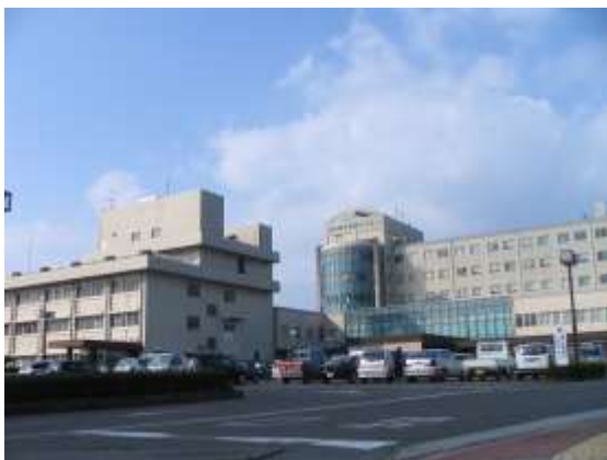
出水総合医療センター全景
